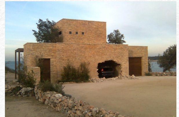
Décor entièrement en staff, teinté par pigment dans le moule pour Transporteur 3 d'Olivier Megaton. Chef décorateur Patrick Durand, production : EuropaCorp, 2008. © Gilles Bontemps
